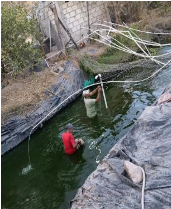
Fig. 2. Mantenimiento a equipo de bombeo.
