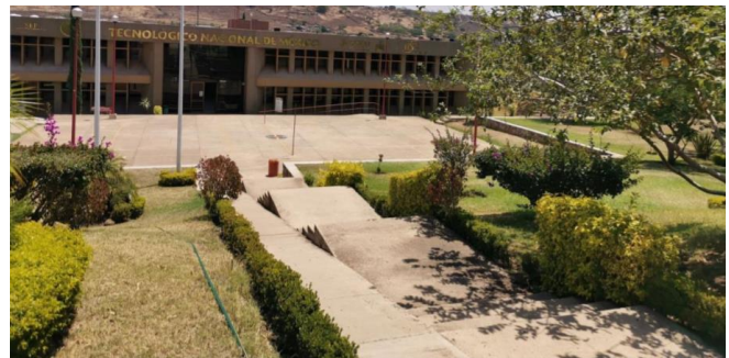
Fig. 1. Rampa uno del edificio A al edificio B.
